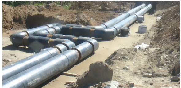
Şəkil 2 Boruların “П” formasında birləşdirilmiş hissəsi
